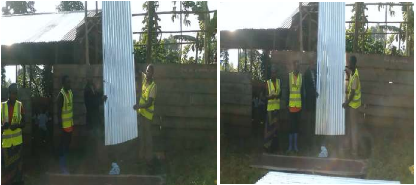
Figure 24 : l'équipe de l'organisation PALPER-RDC réhabilite les écoles secoués par les calamités naturelle dans le territoire de Rutshuru
