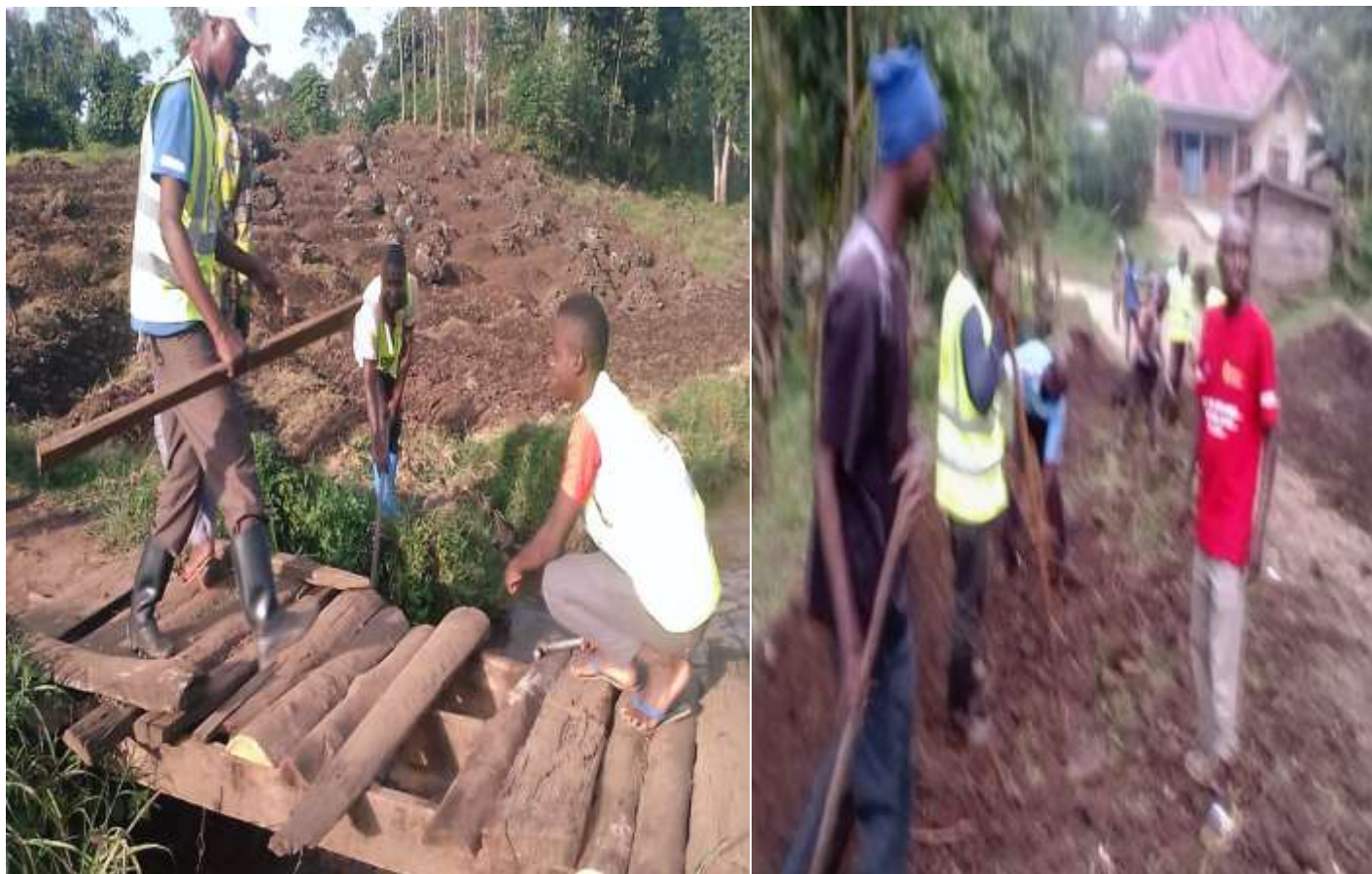
Figure 41 : l'équipe de l'organisation PALPER-RDC ensemble avec la communauté procèdent à la réhabilitation de ponts et aménagement des routes de desserte agricole
