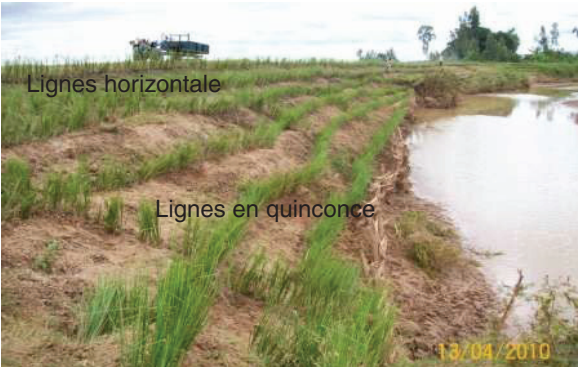
Figure 24b Protection des gabions avec vetiver
